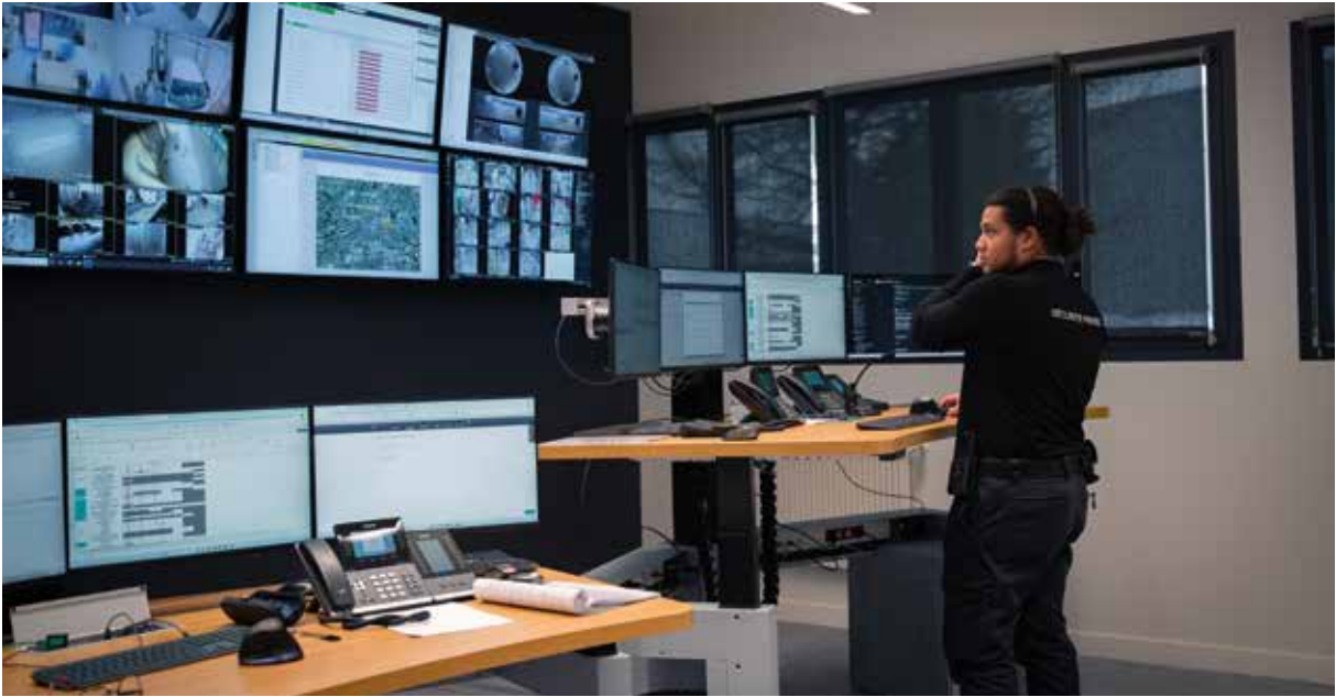
Le poste central de sécurité est composé de deux postes de travail assis/debout et d'une vingtaine d'écrans.
